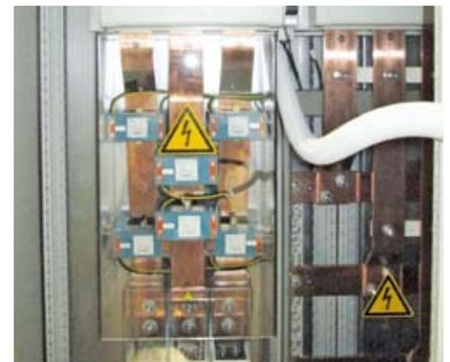
Hohes handwerkliches Geschick erforderte die aufwendige Bearbeitung von Kupferschienen in den Schaltanlagen für Siemens in Ruhstorf.
