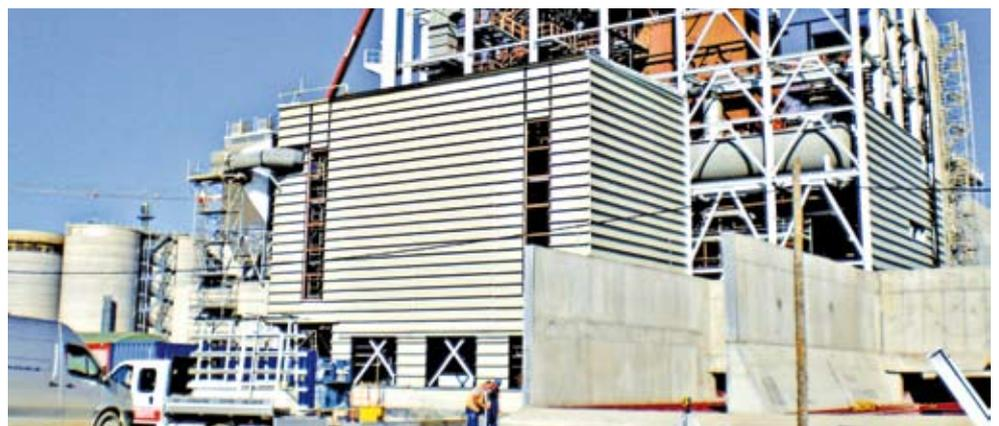
Großinvestition eines österreichischen Holzverarbeiters in Reci/Zentralrumänien: Hier der Blick auf die Baustelle der künftigen Biomasse-Kraftwerksturbine, das „Kesselhaus“, das von der AER installiert wird.
