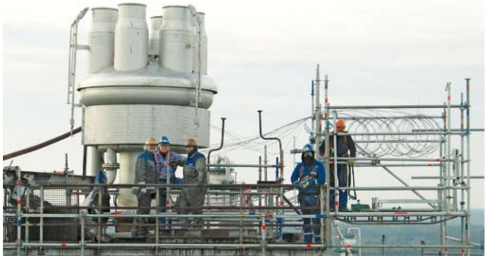
Für den Austausch der Fackelköpfe musste das EFK-Team eine Kabelbahn bis auf 85 Meter Höhe an den beiden Hochfackeln aufbauen: Hier erfolgte dann die Verlegung der neuen Thermoelemente und der Zündkabel für die neuen Brenner unter der Bauleitung von Markus Entfellner. Die Hochfackeln wurden zwar eingerrüstet, die meisten Arbeiten wurden aber mit Gurten von der Steigleiter aus durchgeführt.
