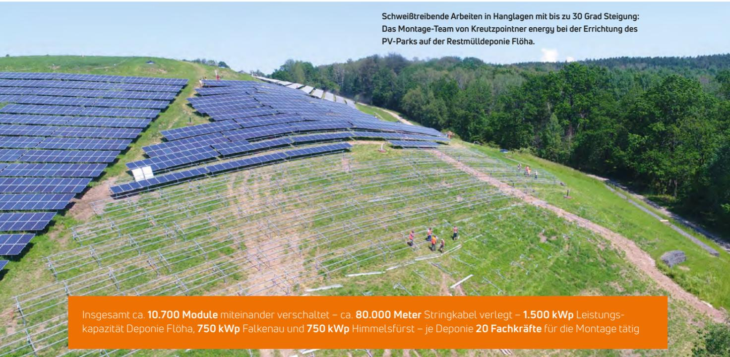
Schweißtreibende Arbeiten in Hanglagen mit bis zu 30 Grad Steigung: Das Montage-Team von Kreuzpointner energy bei der Errichtung des PV-Parks auf der Restmülldeponie Flöha.
