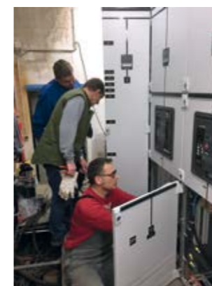
Montage der neuen Kreuzpointner-Schaltanlage im Ziegelwerk 1 bei Schlagmann Poroton in Zeilarn: (von vorne) Ralph Bredl , Thaddäus Richta und Bernhard Maguli vom Auftraggeber Schlagmann.
