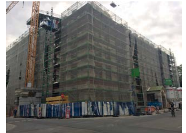
Das historische IHK-Stammhaus misst eine Grundfläche von über 15.470 m 2 und wird kernsaniert. Bauleiter Jens Bechert (li.) und Obermonteur Harald Wiesmayer vor Ort.
